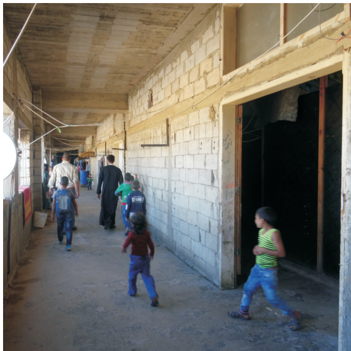
Recorriendo uno de los edificios-albergue.
